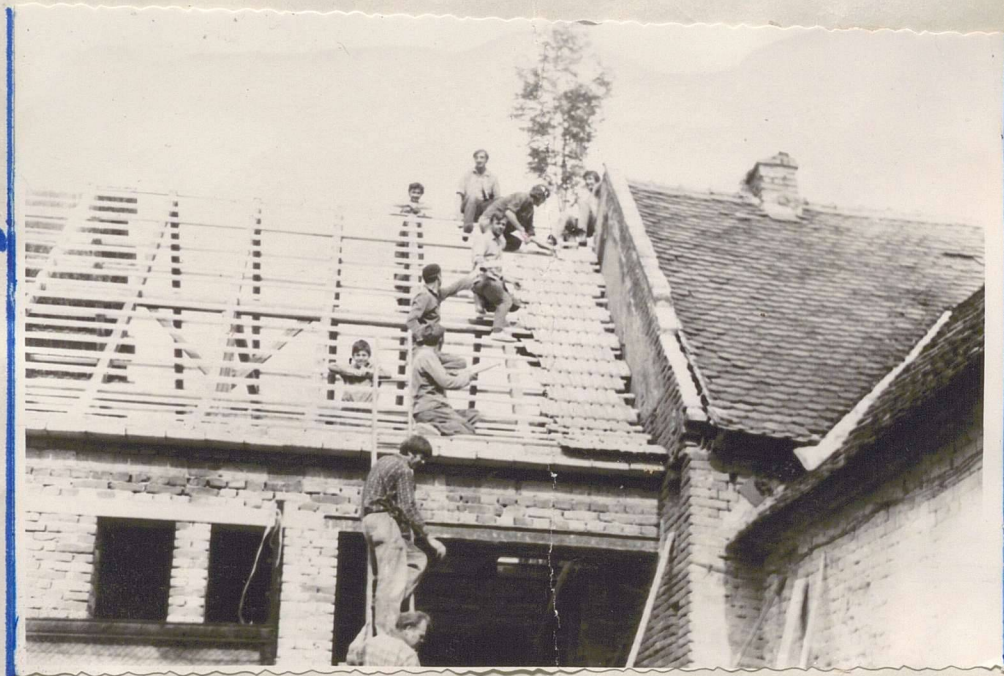
POŽÁRNÍCI PŘI VÝSTAVBĚ ROD. DOMKU
