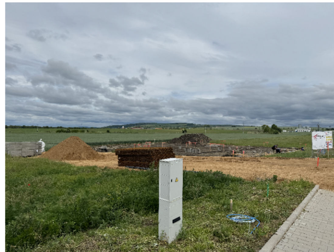
Pohled na rozestavěnou lokalitu u silnice III/41612 do Moutnice.
