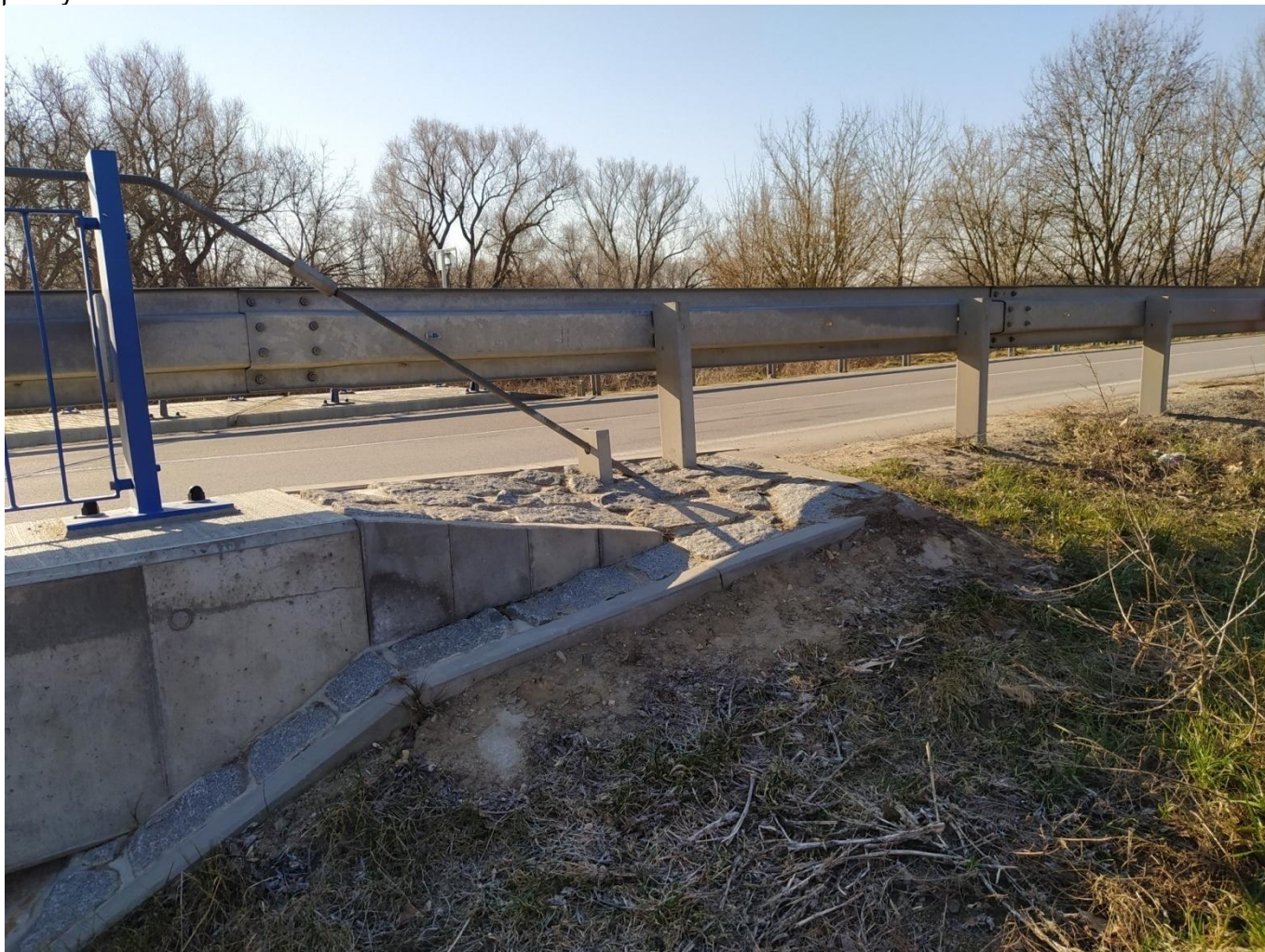
Obr. 3 Ochranná svodidla komunikace II/381
