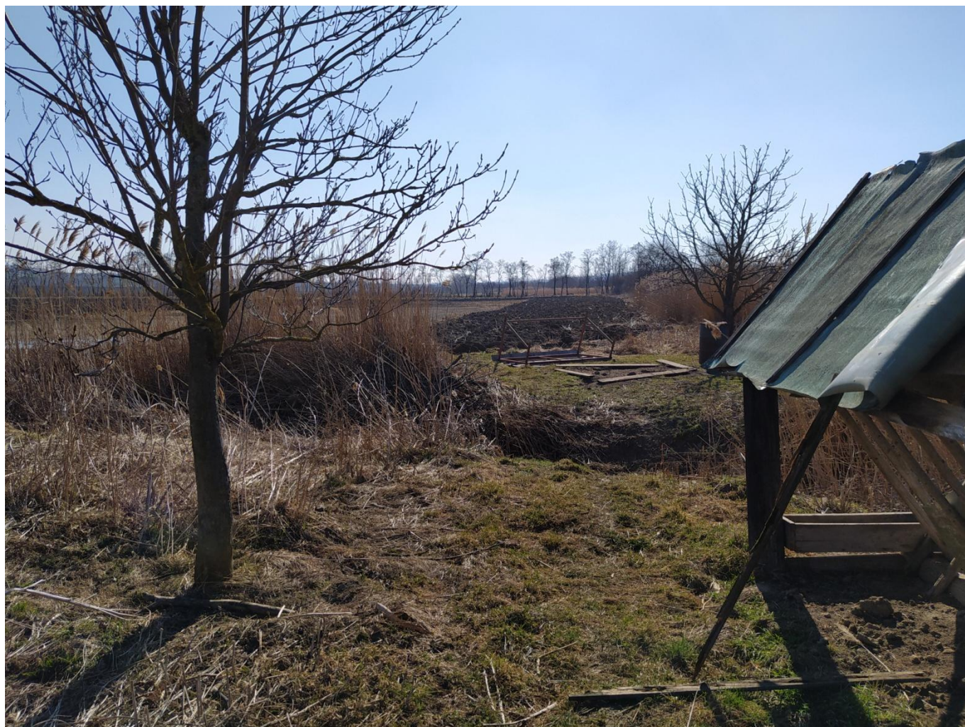
Obr. 3 Krmelec a odvodňovací příkop v trase cyklostezky
