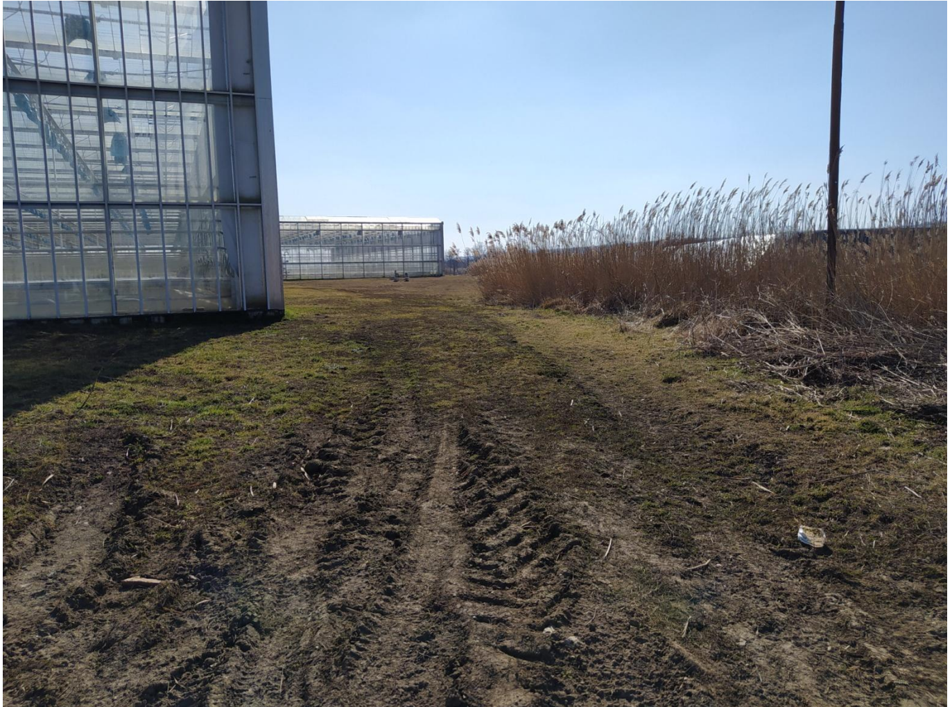
Obr. 1 Začátek úseku cyklostezky při sjezdu z polní cesty VC21a
