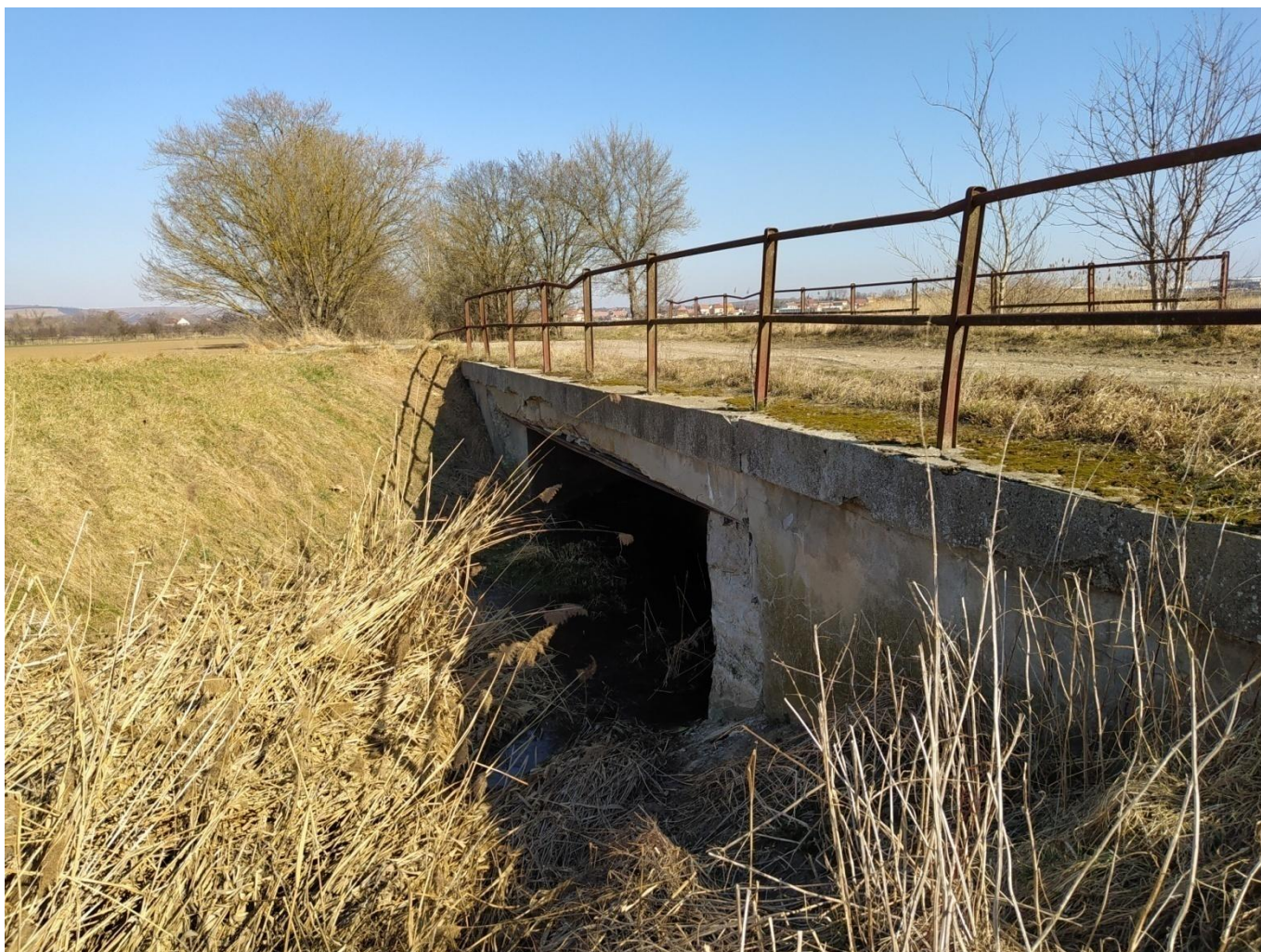
Obr. 3 Most M1 přes vodní tok
